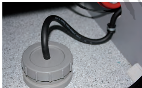
Abb. 13.1 Netzanschluss herstellen
