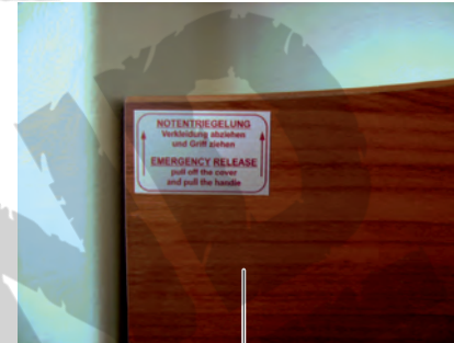
Abb. 8.4 Notentriegelung Eingangstür
